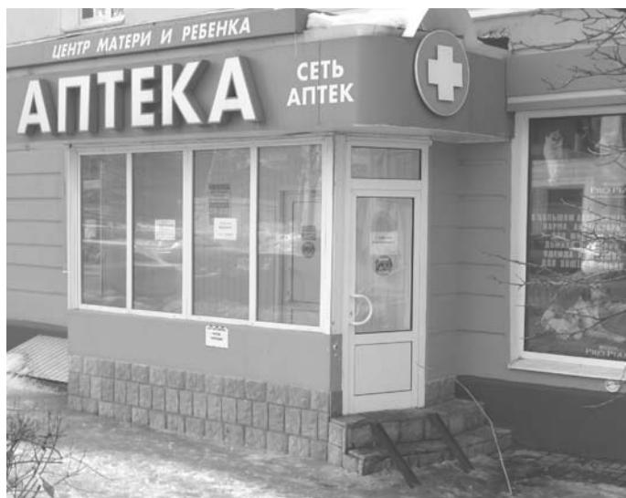
Рис.1. Центр матери и ребёнка «ИНВАПРОМ», аптека, г. Тамбов (угол наклона и расстояние между ржавыми уголками – пандусом, ширина двери не позволят инвалиду-колясочнику в принципе попасть в помещение центра-аптеки)
